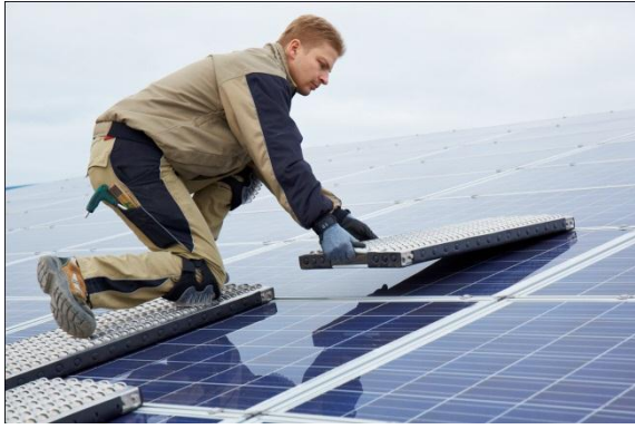
Abb. 3: Einhängen der SMB Solar Multiboards
